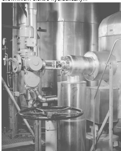
Podgrzewacz wysokoprężny w elektrowni atomowej wyposażony w odwadniający zawór regulacyjny ZK 29
